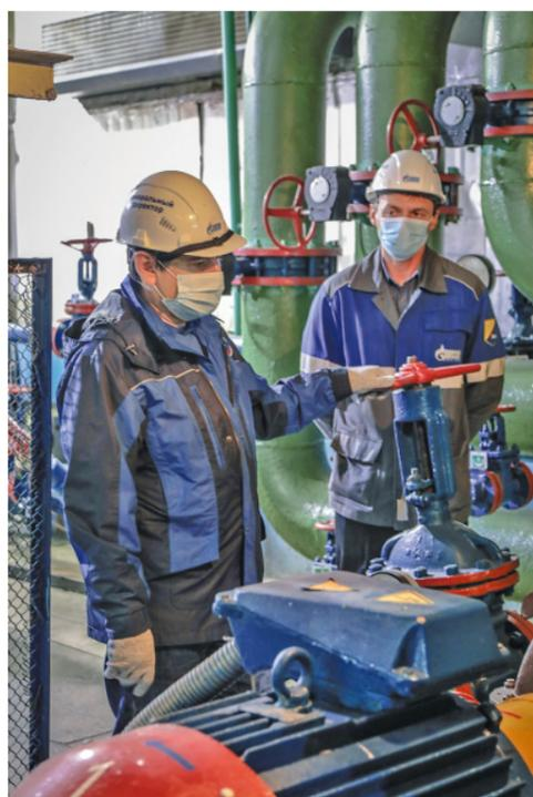
На КС-03 генеральный директор отметил, что на сетевых насосах утилизации КЦ-1 поменяли положение задвижек и обеспечили доступ для обслуживания
