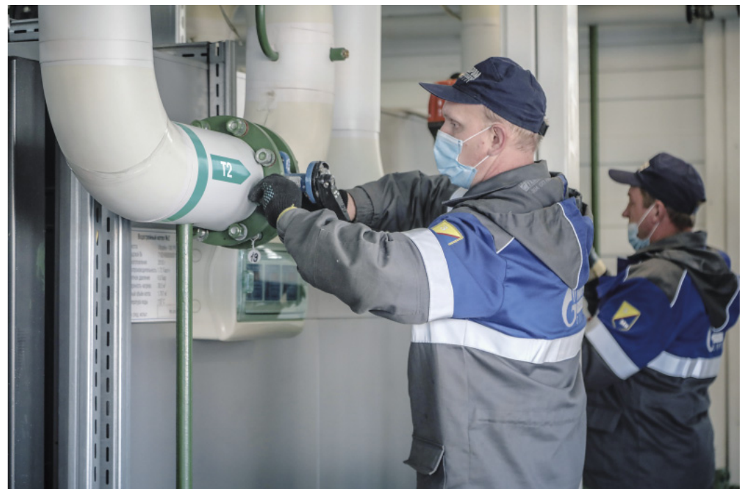
Операторы Игорь Шуляковский и Алексей Томилов проводят ревизию запорной арматуры котельной Тюменского АВП
