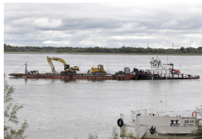
Технику в Сургутское ЛПУ тоже отправляют по воде
