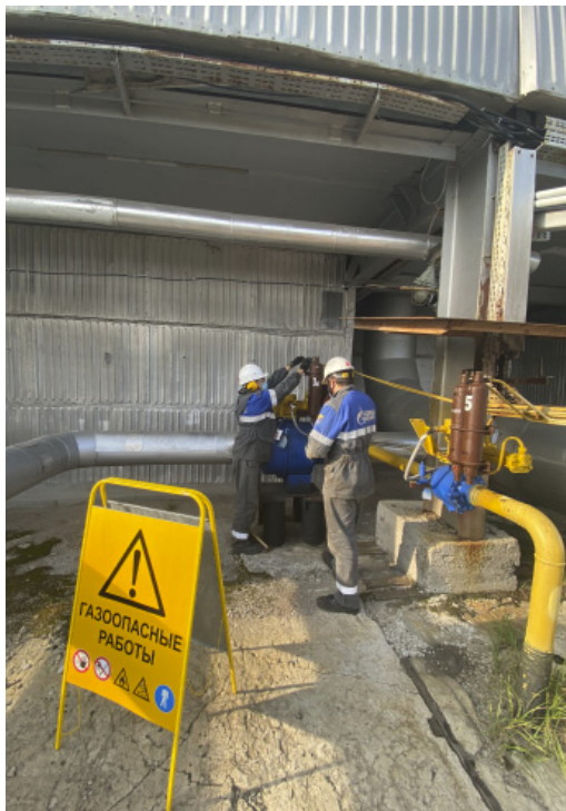
Работники службы ГКС Губкинского ЛПУ производят техобслуживание ЗРА
