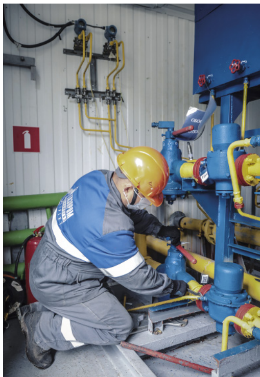
Линейный трубопроводчик Степан Липкин (КС-10) ведет подготовку к демонтажу второй ступени системы редуцирования ГРС Ярквская
