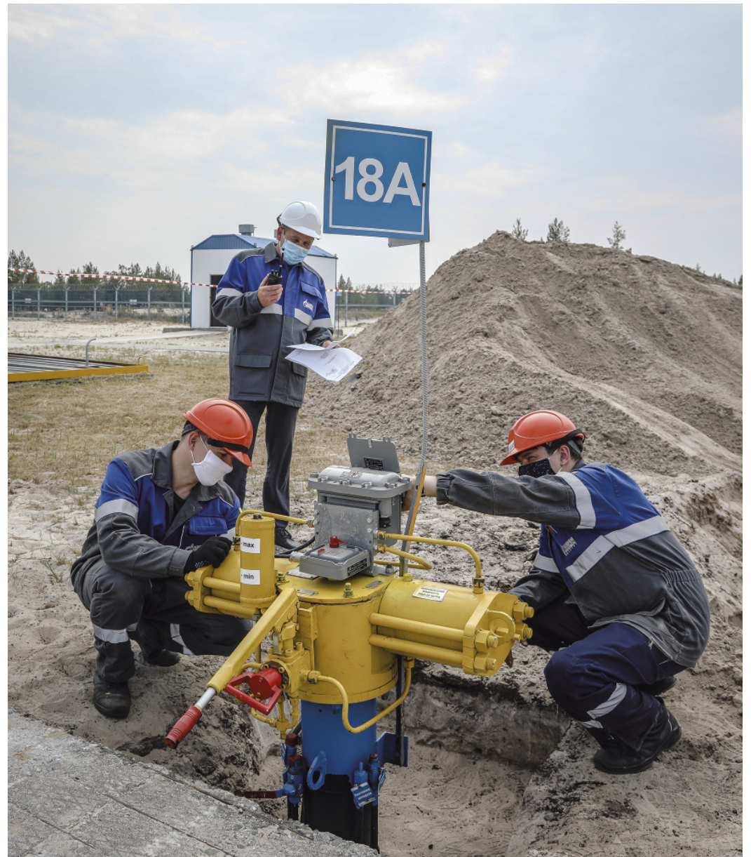
Слесари КИПиА Тимур Юнусов и Василий Горбань (Ортыгунское ЛПУ) готовят запорную арматуру для проверки работоспособности системы аварийного отключения цеха
