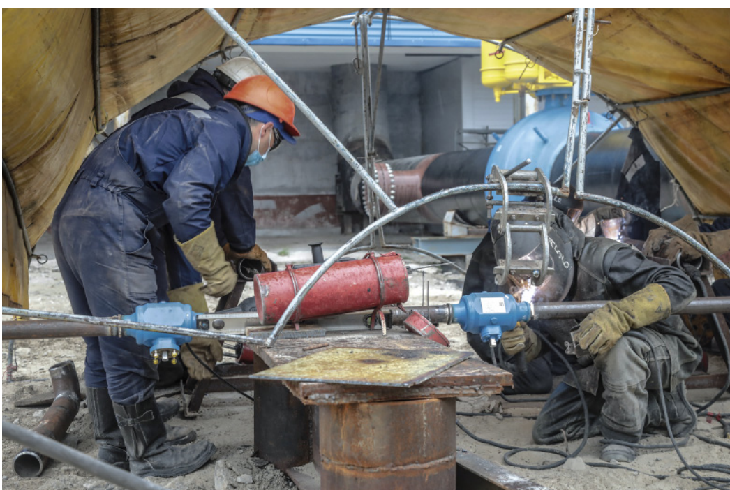
Работники Ноябрьского АВП ведут сварку малого трубопровода на КС-2
