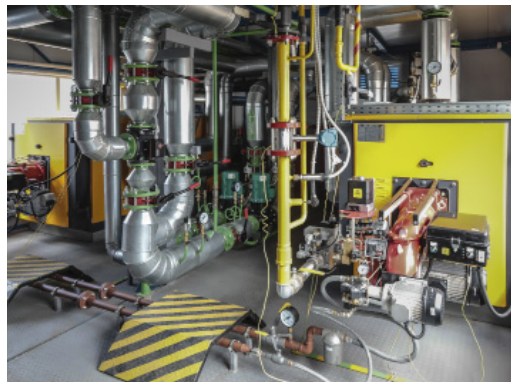
Новая котельная Ишимского ЛПУ готова к любым морозам
