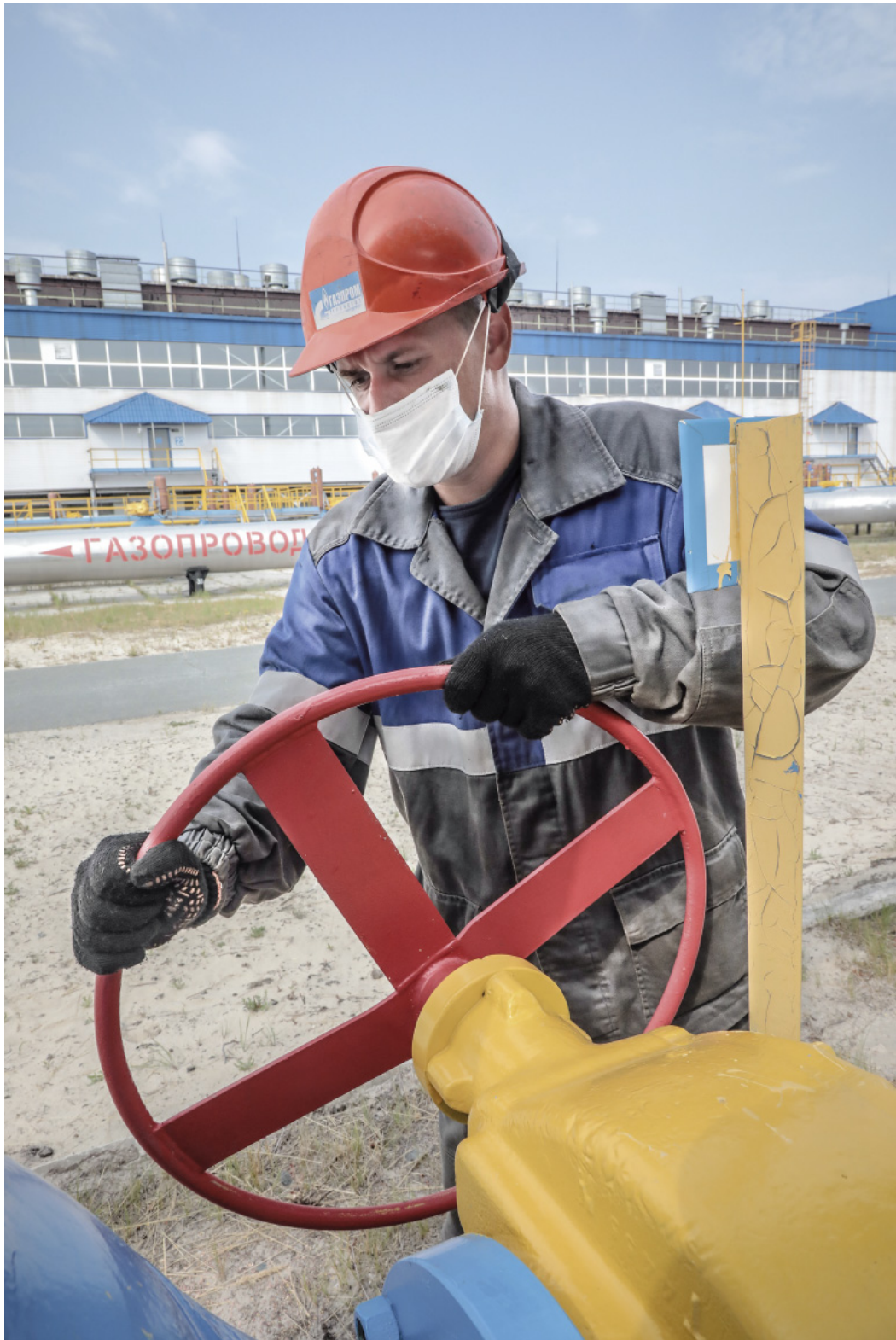
Слесарь по ремонту ТУ Анатолий Медвинский (Ортыгунское ЛПУ) переустанавливает кран ЗРА
