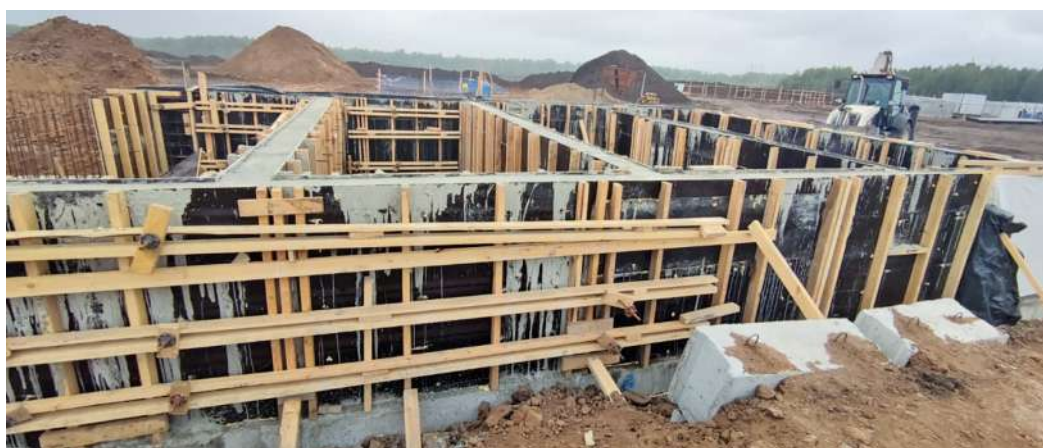
Газификация в действии: идет заливка фундамента под будущую ГРС «Ишим-2»
