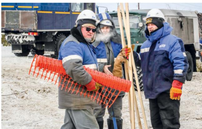
Для ограждения склонов опасных зон котлована перед началом работ устанавливают специальную сетку
