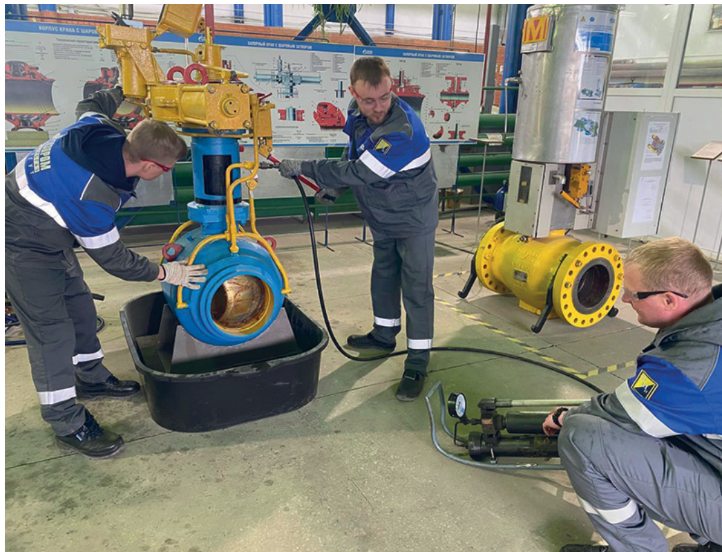
Перестановка крана при помощи аварийного комплекта. Все наглядно и по-настоящему (фото предоставлено УПЦ)
