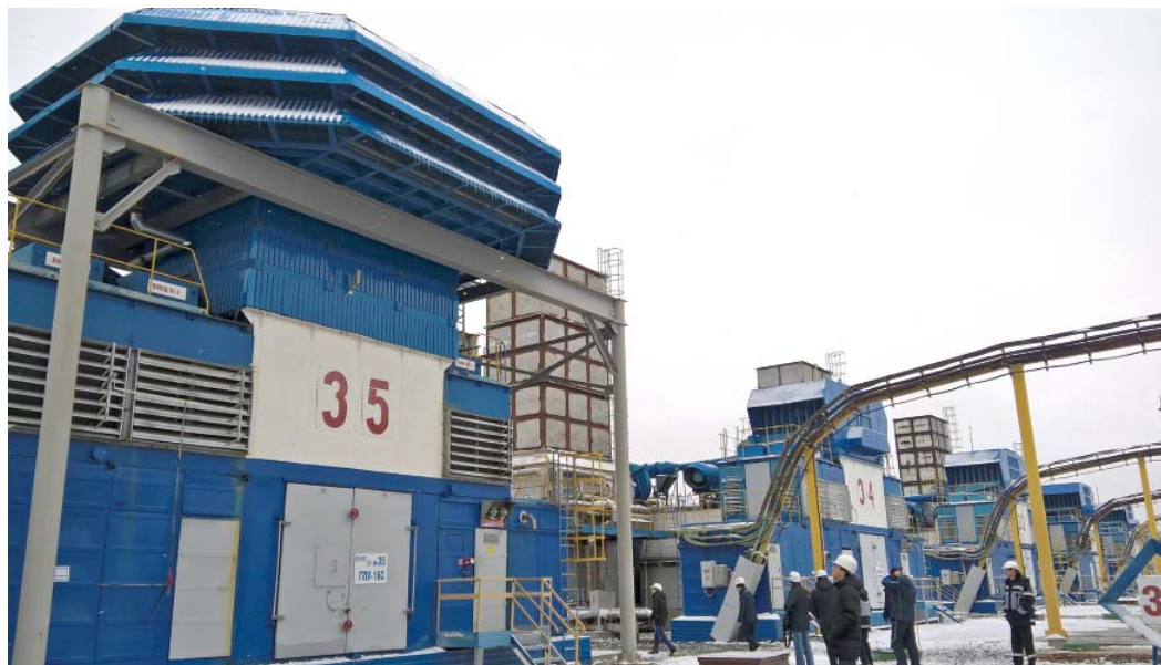
Одно из изобретений, внедренных в Обществе, – новая модель КВОВ (воздухоочистительного устройства) ГПА на КС-1
