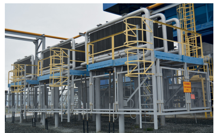
Блок радиаторов-конденсаторов возле одного из ГПА (система ГЕТ)
