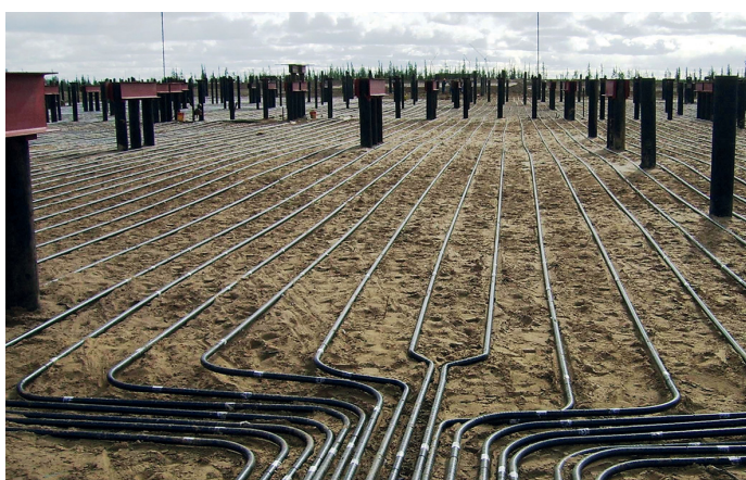
Монтаж системы ГЕТ. Это как «теплый пол», только наоборот
