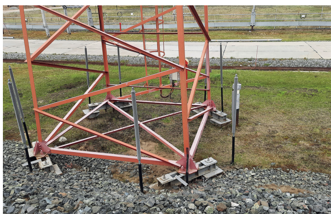
Стержни СОУ, заглубленные у свайного фундамента мачты
