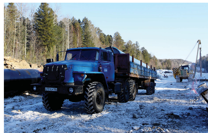
«Урал» подвозит очередную новую трубу для замены
