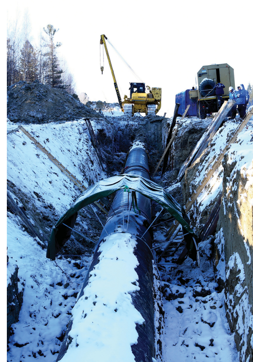
Один из разработанных котлованов. Здесь будут вырезать дефект
