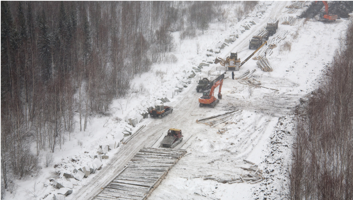
Укладка лежневки – процесс трудозатратный, и такая дорога обходится недешево (фото: Вадим ПИХНОВСКИЙ)
