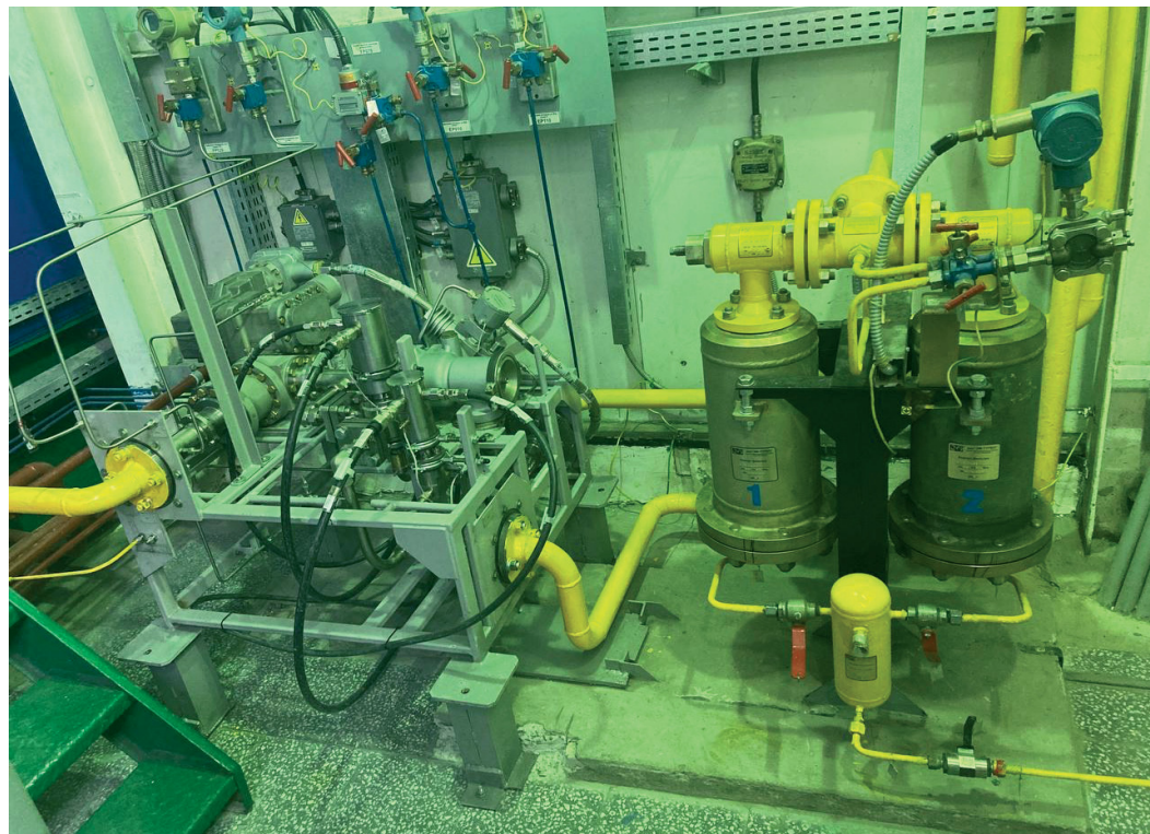
Отечественная аппаратура на двигателях: еще один пример успешного замещения узлов в системе ГПА (фото: КС-6)
