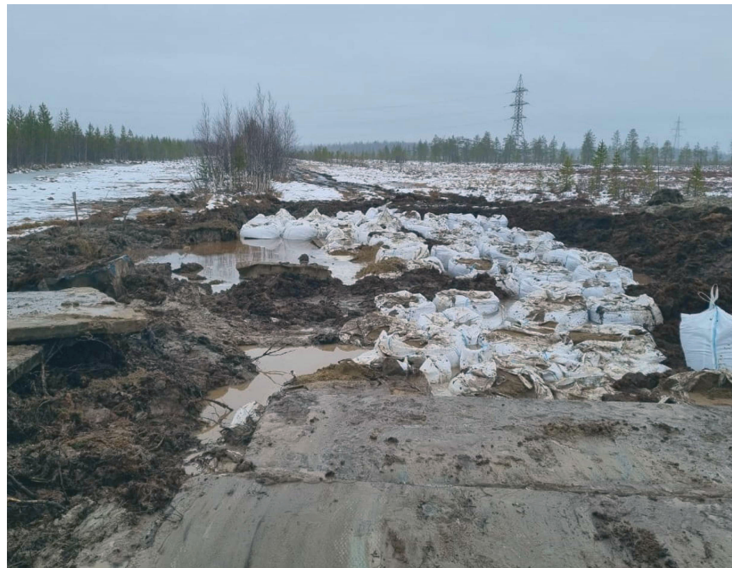
Биг бэги – большие мешки с песком, ставшие фундаментом для спецтехники (фото: КС-1)
