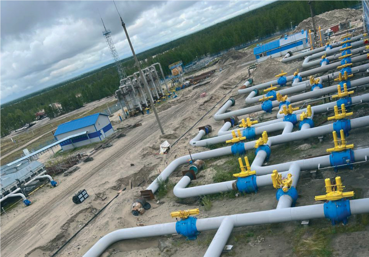
На втором цехе КС-02 нашими инженерами уже проделана большая работа по восстановлению (фото: Пурпейское ЛПУ)
